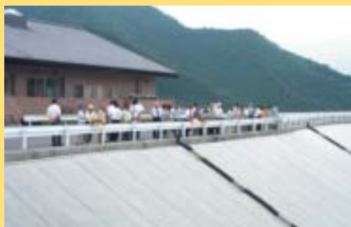
小俣処分場（足利市）
