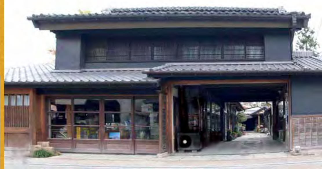
蔵造の店舗「見世蔵(店蔵)」。地区内には江戸後期から明治初期の見世蔵が8棟あります(写真上は平澤商事の見世蔵)
