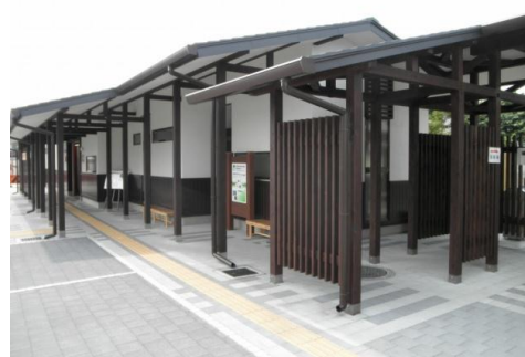
公衆トイレの整備が行われました。 （鹿沼市まちなかの駅かぬま）
