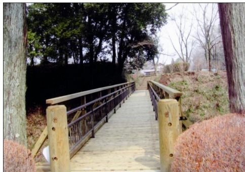
木橋の整備が行われました。 （大田原市黒羽城址公園）
