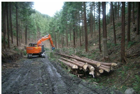
間伐材を搬出するための作業路を整備しました。
