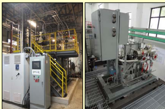
カリナサイクル発電設備（左）と発電機（右）
