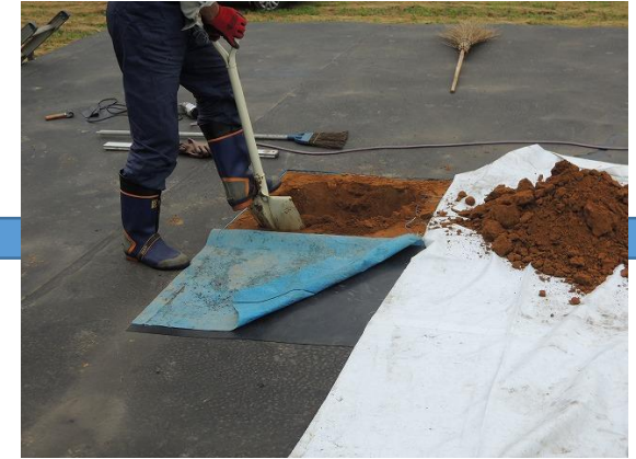
③覆土の掘削
