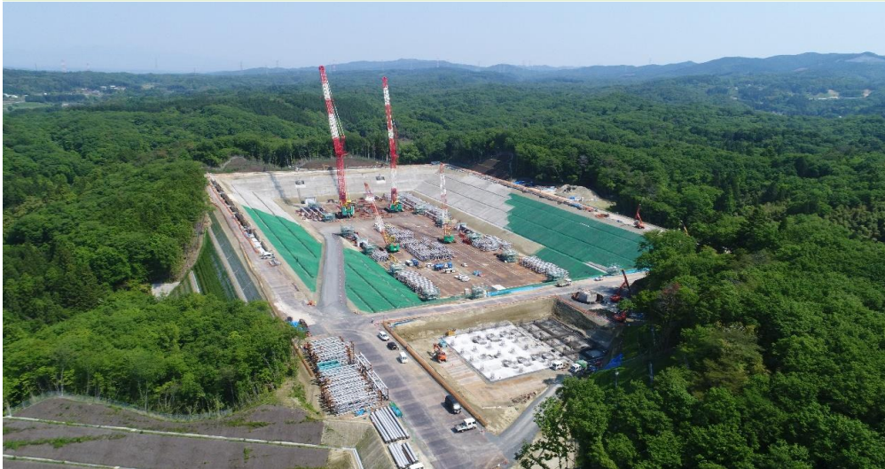
③ 埋立地（被覆施設）の外周基礎設置
