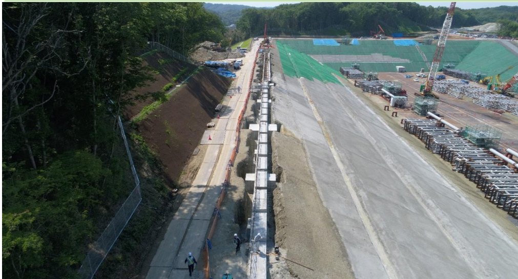
③ 埋立地（被覆施設）の外周基礎設置
