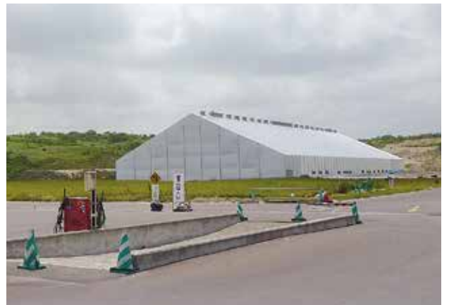
稚内市廃棄物最終処分場 (PFI方式)
