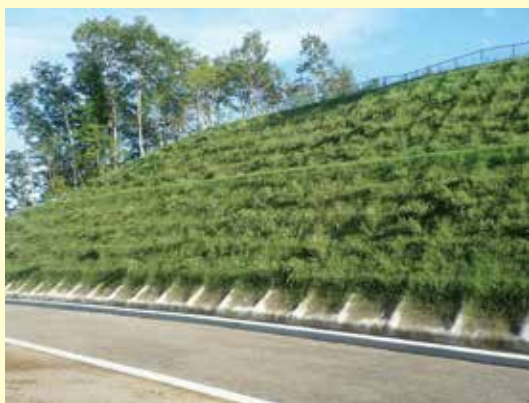
町道備中沢線拡幅工事現場
