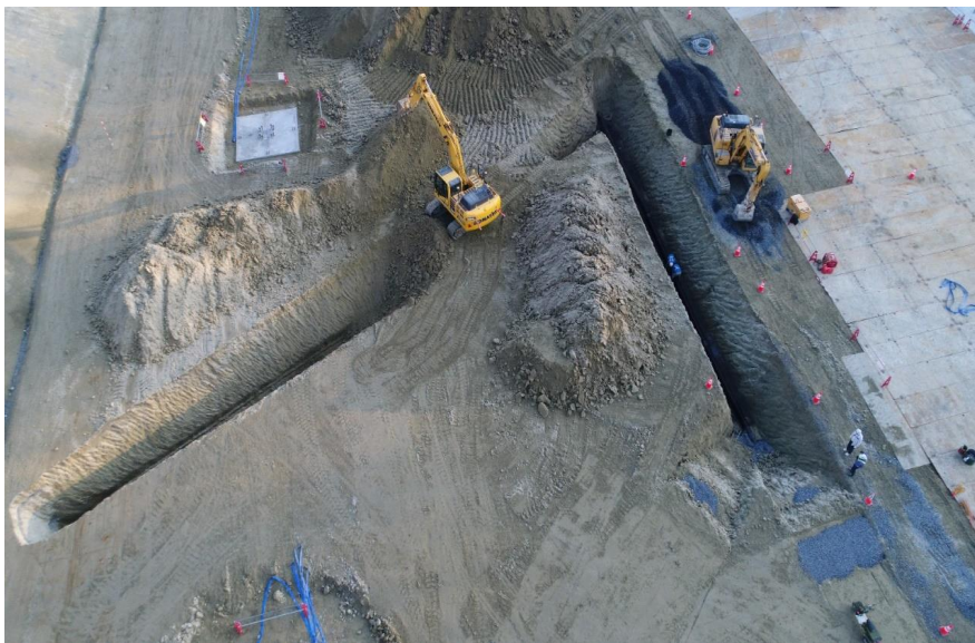
③ 埋立地（被覆施設）の地下水集排水管の設置
