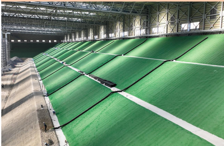
③ 埋立地内の遮水シート設置状況
