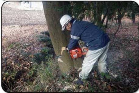
支障木の伐採作業
