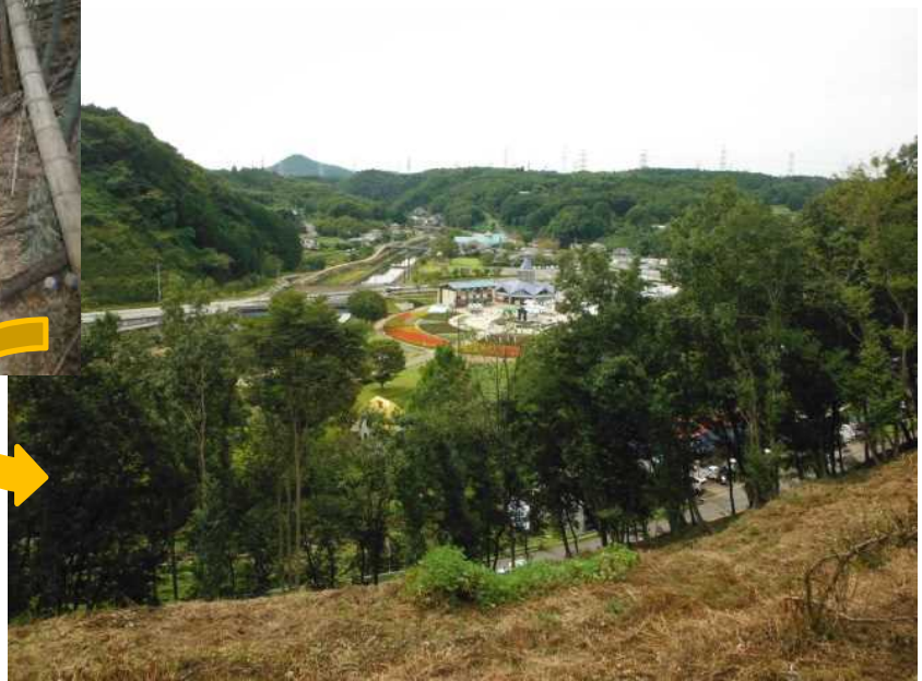
整備後 荒れた竹やぶがなくなり視界も良好
