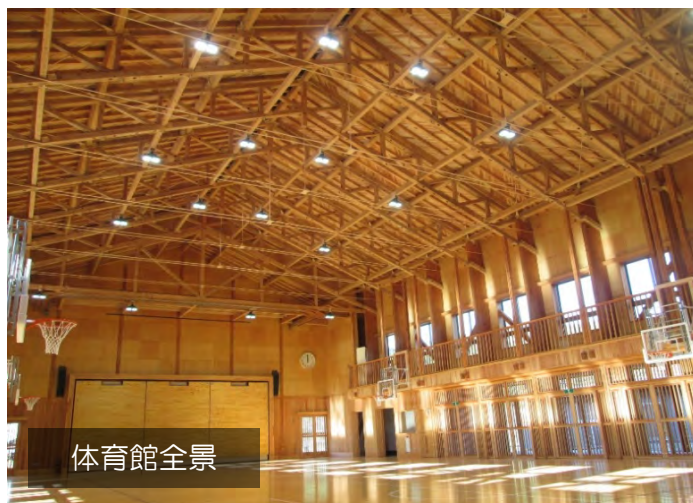
県林業センターにて、乾燥スケジュールの指導及び構造材全数（7126本）の強度（ヤング率）・含水率を測定を実施
