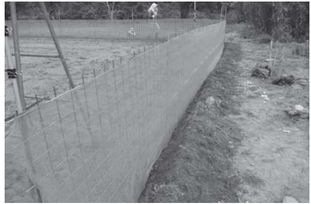
写真2 防風ネットの埋め込み
