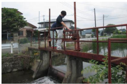
緊急点検の実施状況
