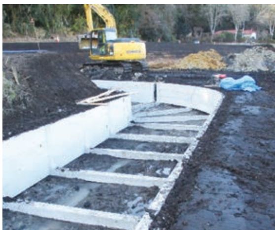
排水路工事の状況
