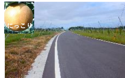
整備された道路や排水路
