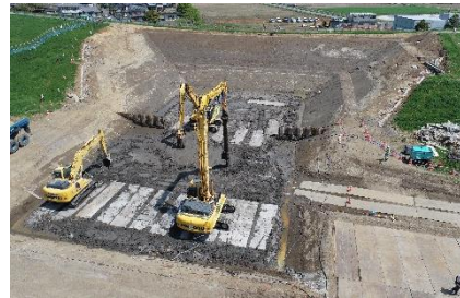
パワーブレンダー工法 (地盤改良)
