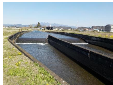
市の堀用水地区 (整備前) (塩谷南那須農業振興事務所)
