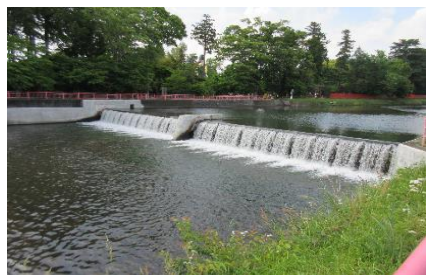
緊急点検を実施した頭首工
