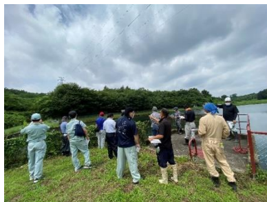
堤体法面を点検している様子
