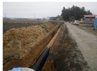
暗渠型排水路の施工中の状況
