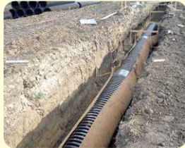
用排水路の暗渠化による農道の拡幅
