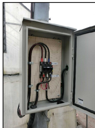
④②でみなさんが見ていた設備 (常用/非常用切替スイッチ) ここにEVの電気を接続します(注意)
