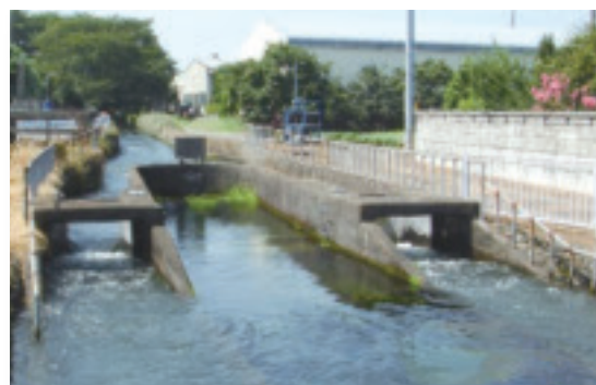
機能診断に基づく保全管理が行われている 横手・三ヶ村分水工（足利市）
