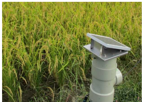
写真：とちぎの星のほ場に設置された自動給水装置
