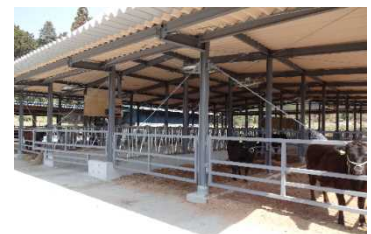
畜産クラスター事業により整備された繁殖牛舎
