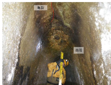
↑亀裂や崩落の様子
