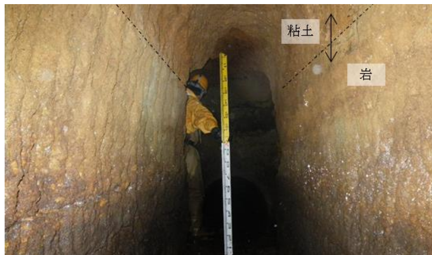
↑素掘ずい道内部の様子
