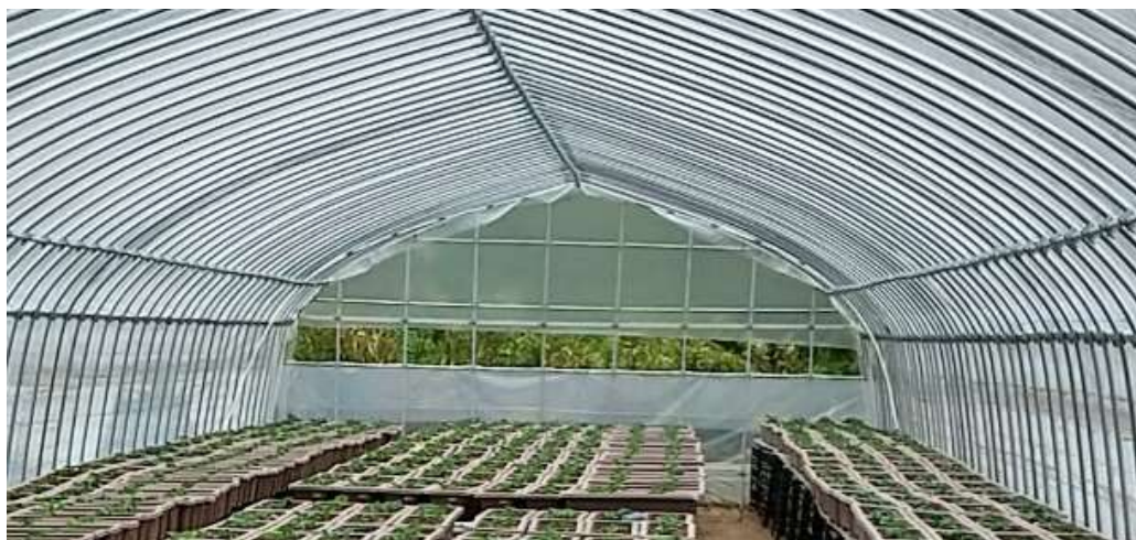
(妻面を除去した様子)
