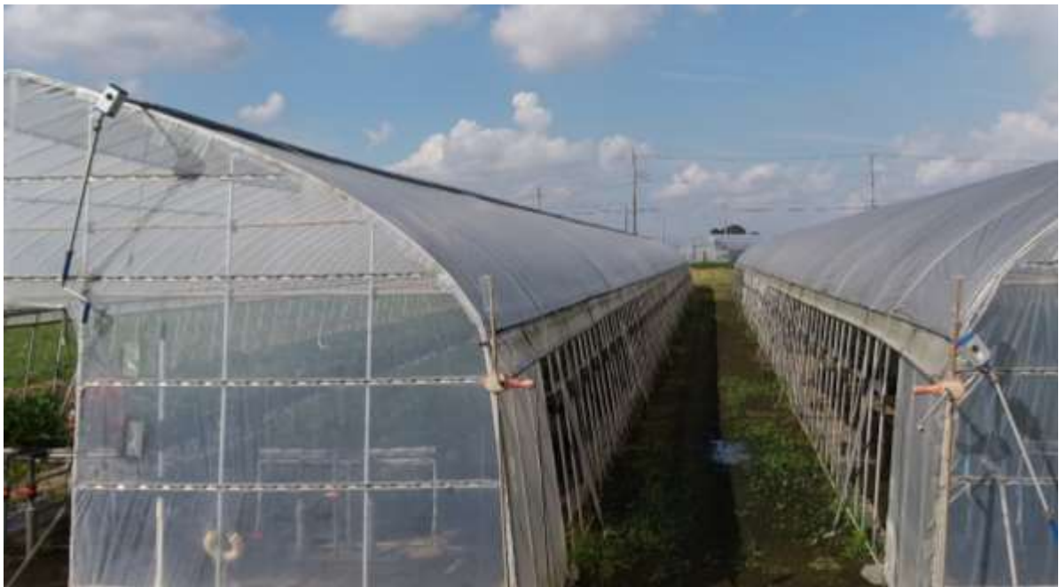
(遮光ネットをくるくる換気で開閉 (左が開、右が閉))
