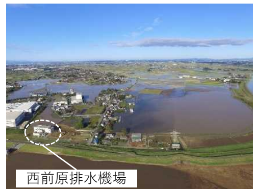
湛水した排水機場周辺
