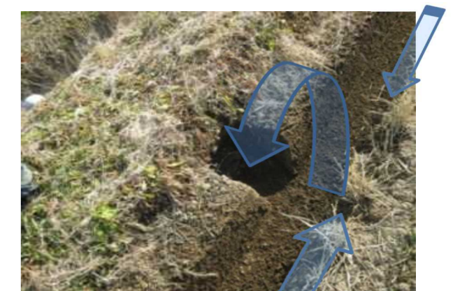
図2 速やかな排水対策の良い例 明渠と排水口がしっかり連絡している(矢印：水の流れる方向)
