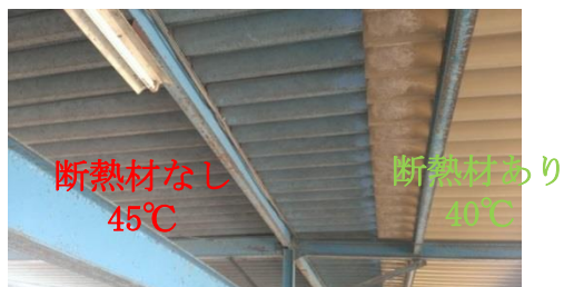
屋根裏断熱資材の有無による放射熱の比較
