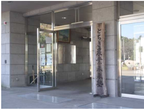
教育研修棟入口です ※農大直売所が行われるところです
