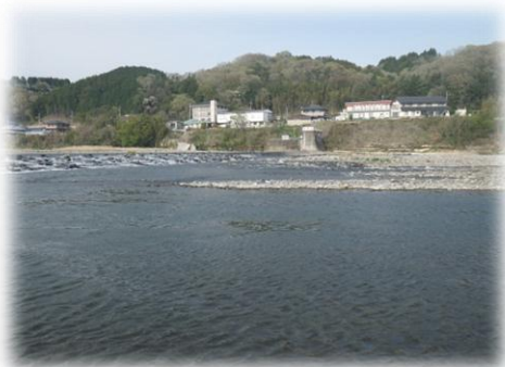
調査地点(三川又堰)
