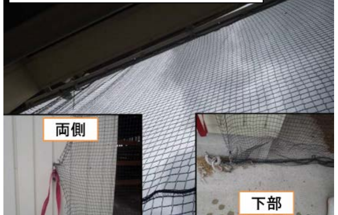
2 牛舎開口部の防鳥ネット設置
