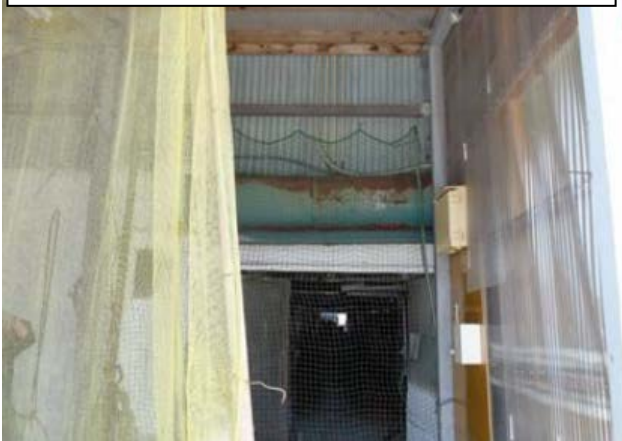
1 畜舎出入口の二重の防鳥ネット設置
