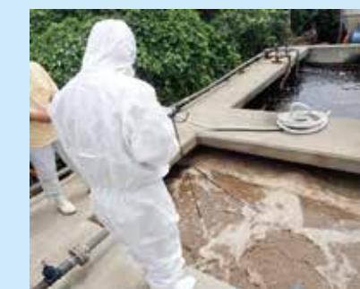
排水処理施設調査
