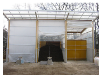
脱臭試験用堆肥舎
