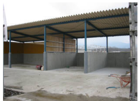
図6 発酵施設(堆肥舎)
