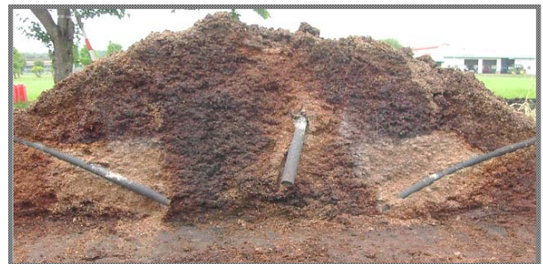
図13 埋設した通気管
