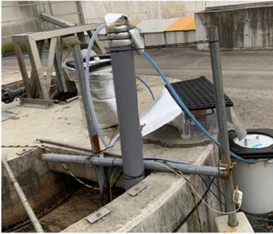
写真1 曝気槽に設置した硫黄脱窒装置
