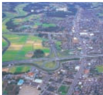
北関東自動車道
