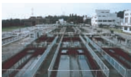
北那須浄化センター水処理施設（大田原市）
