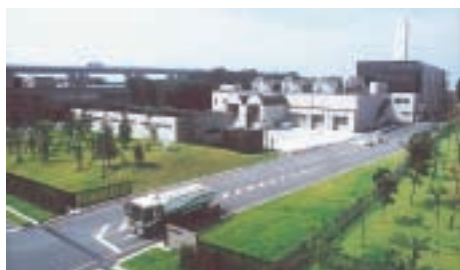
栃木県下水道資源化工場（宇都宮市）
