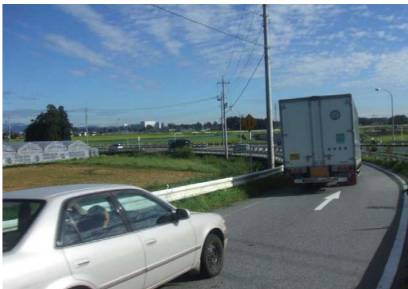
2期工区の現状（急カーブ危険箇所）
