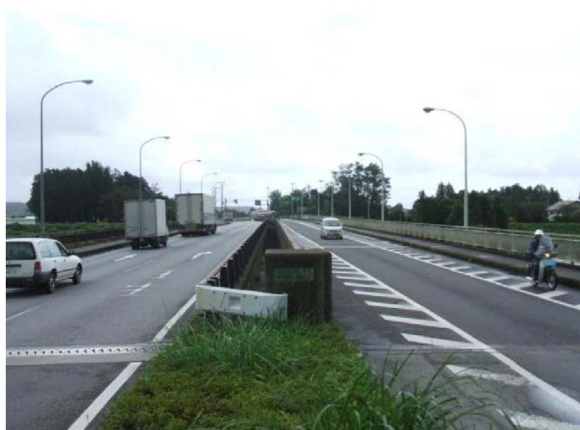
1期工区の供用状況（小倉橋）
