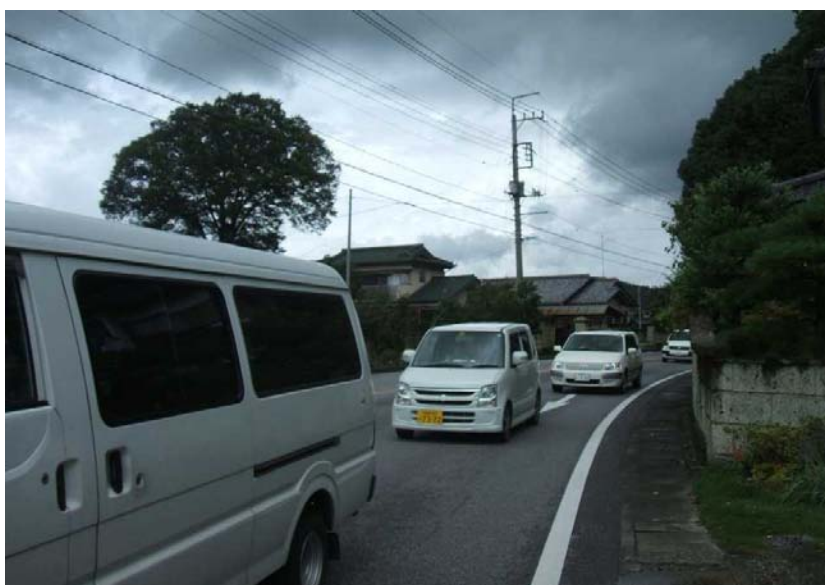
2期工区の現状（狭隘な区間）
