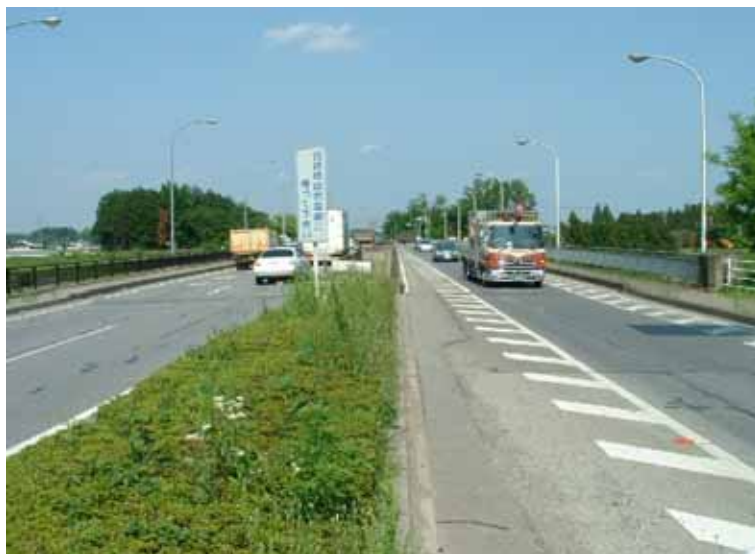
写真3:小倉橋付近の供用状況
