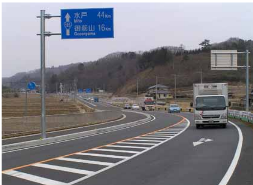
写真3: 供用区間状況(2期工区)
