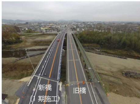
(施工中 (1期施工))
