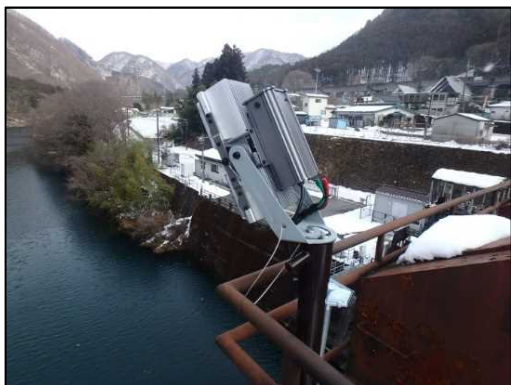
ダム湖面を照らす投光器をLED化
