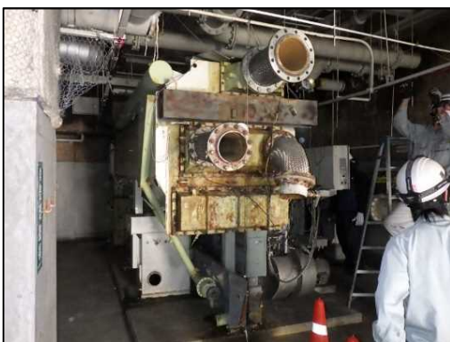
既存冷温水発生機
