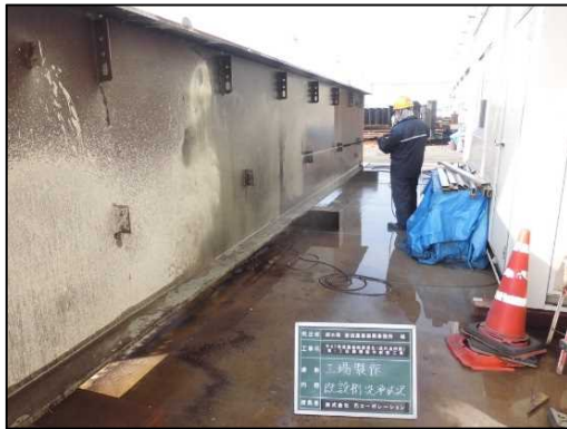
既設桁洗浄状況
