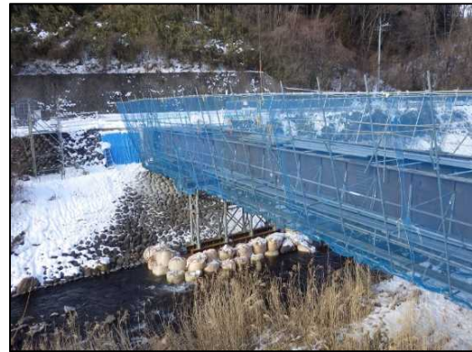
桁架設後
