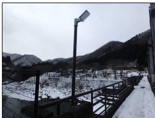
通路橋の照明をLED化
