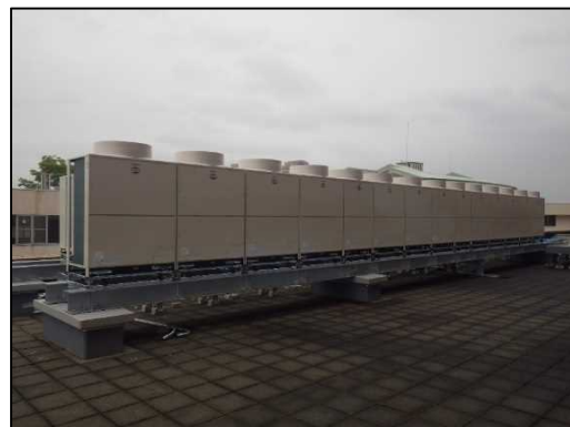
空気熱源パッケージ型空気調和機
