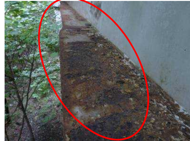
排水装置：腐食・破断【赤堀橋】
