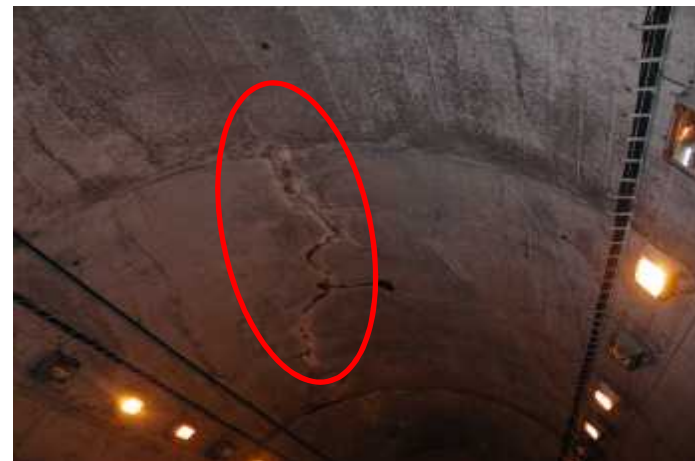
覆工：ひび割れ【神主山トンネル】
