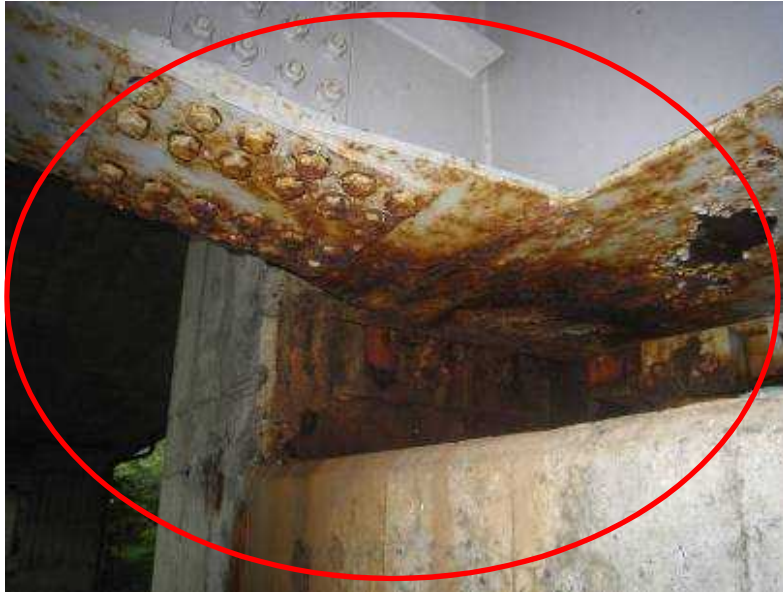
桁：漏水・腐食、橋台：鉄筋露出【安良沢大谷橋】
