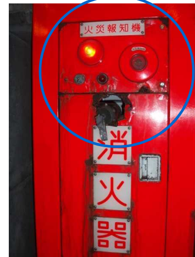
消火栓:腐食 【鳴虫山トンネル】
