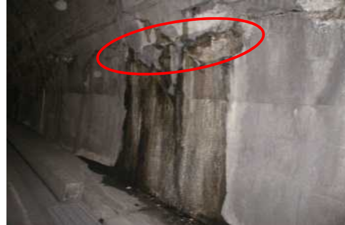
覆工：ひび割れ【神主山トンネル】
