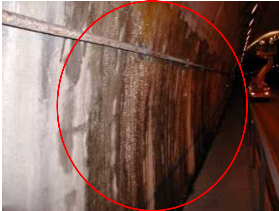
覆工：漏水【神主山トンネル】
