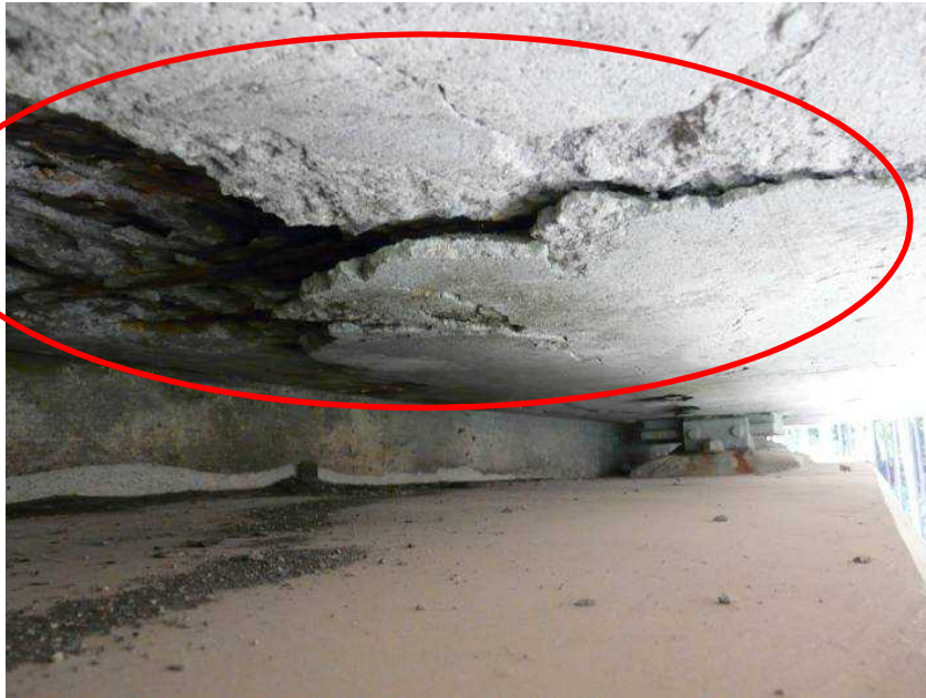
床版:はく離・鉄筋露出【室瀬高架橋】
