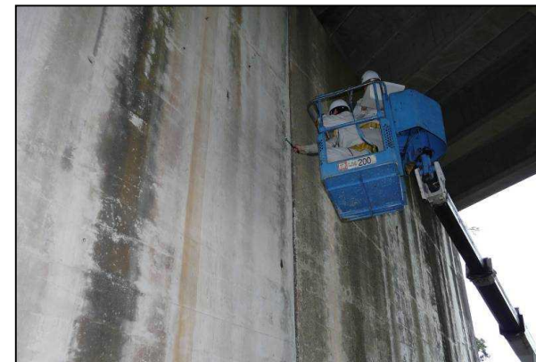
橋梁点検実施状況
