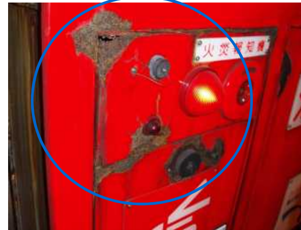
消火栓:腐食【神主山トンネル】
