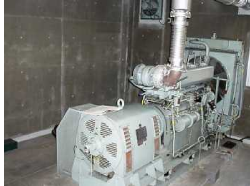
トンネル設備等の自家発電装置:耐用年数超過
