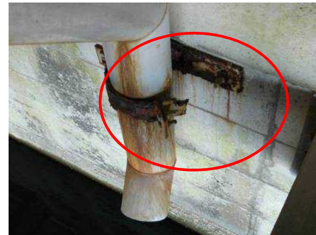
排水装置：腐食・破断【赤堀橋】
