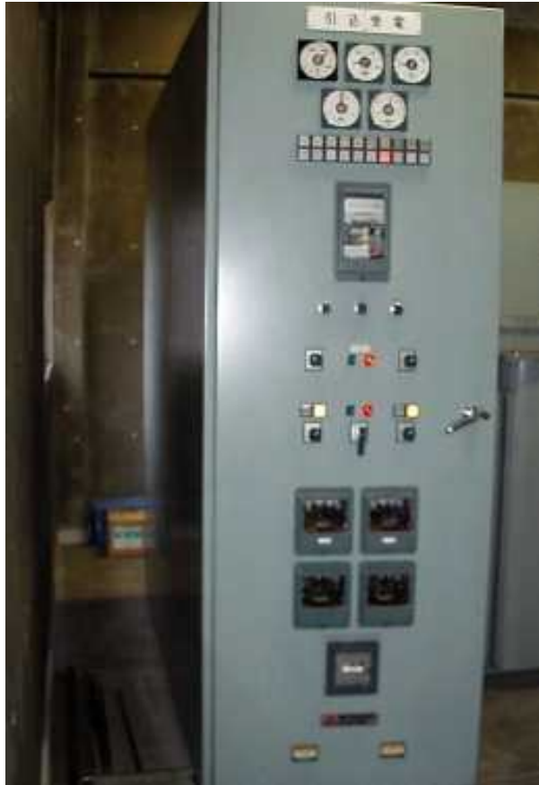
インターチェンジ・パーキングエリア設備の 受電盤:耐用年数超過
