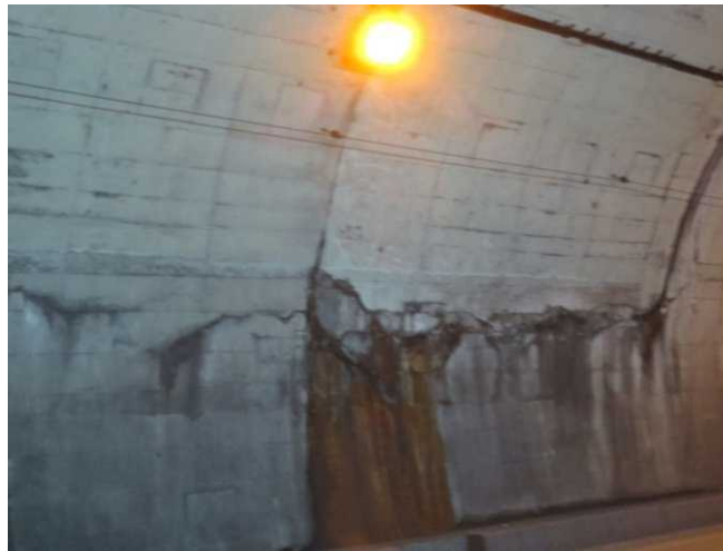
覆工のひび割れ、漏水 (鳴虫山トンネル)
