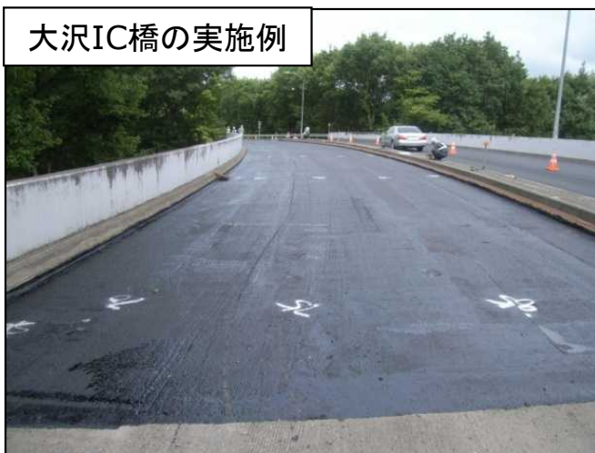
高機能防水工（床版上面）
