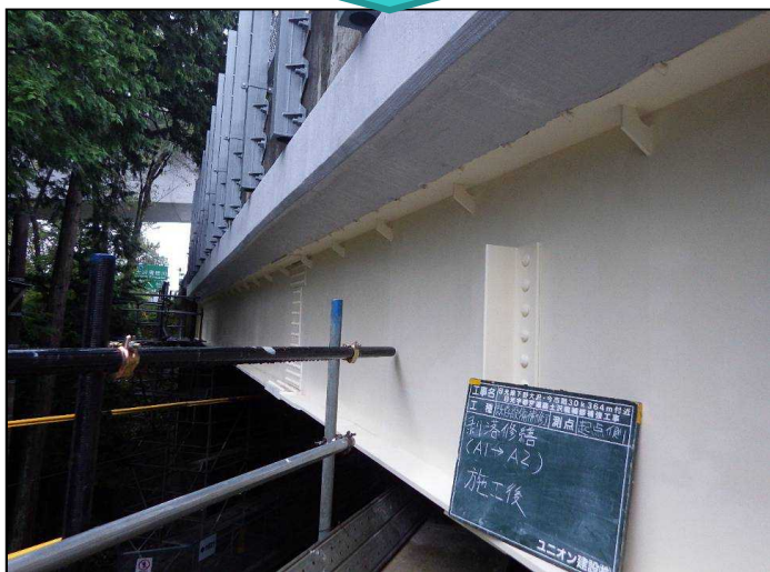
剥落防止工(床版下面)
