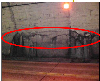
トンネル覆工損傷状況
