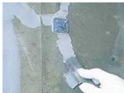
▲取り付けパイプの接着とシーリング
