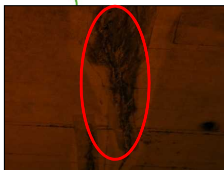
トンネル覆工損傷状況
