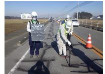
アスファルト注入工施工状況
