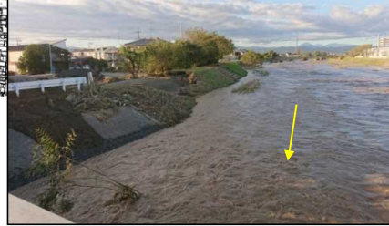
② 秋山川(大橋上流右岸)決壊箇所状況
