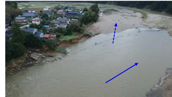
堤防の決壊状況
