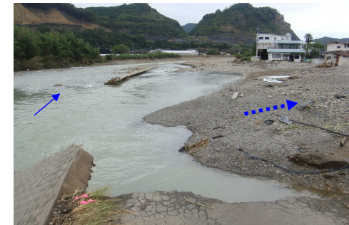
護岸の被災状況
