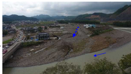
堤防の決壊状況
