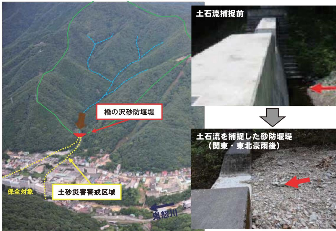
砂防堰堤による土石流の捕捉効果（橋の沢砂防堰堤 日光市）
