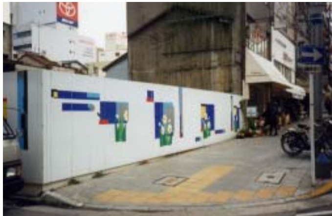
工事用仮囲いの塀にペイントを施し、単調で近寄りたがいの空間となることを緩和している。(名古屋市)
