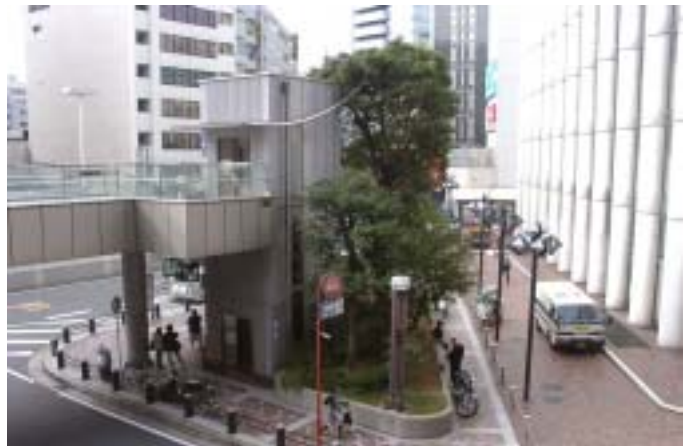
アルミとガラスによる耐久性の高い材料を使ったエレベータシャフトは、メンテナンスが容易で都市的な景観に調和している。(横浜市)
