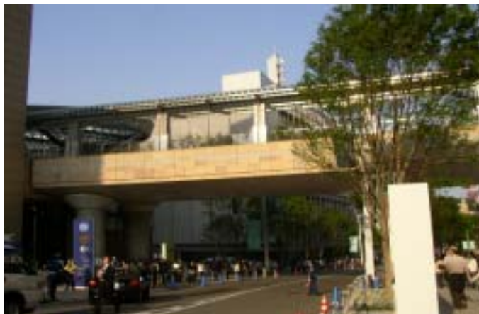
建築物などの周辺の施設とデッキの色彩を調和させ、一体的な空間を形成している。(東京都港区)
