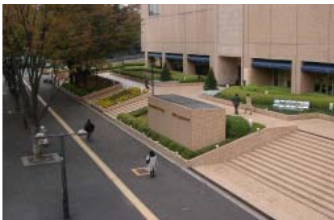
排気塔、舗装、建築の外装の色彩を、圧迫感を抑制した明るい色彩に統一し、緑と調和した一体的な空間を形成している。(東京都新宿区)
