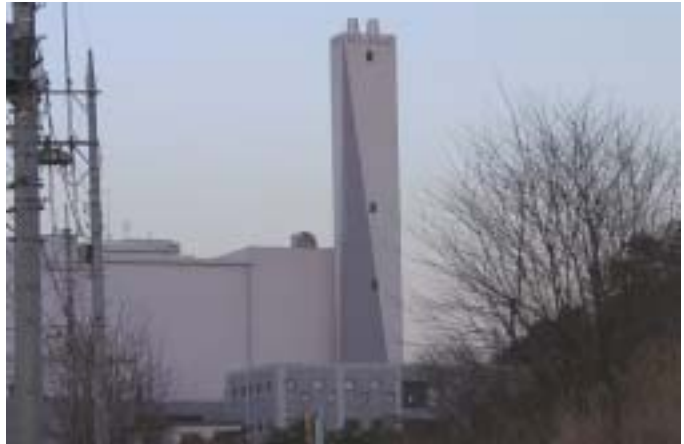
シンプルな形態に幾何学的な意匠を施し、施設全体が一体的なまとまりある印象を与えている。(栃木市)
