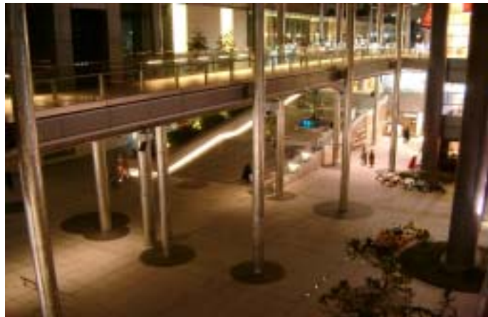
デッキの手すりや階段、カスケード、舗装など様々な場所に照明を設置し、にぎわいの空間を演出している。(東京都港区)
