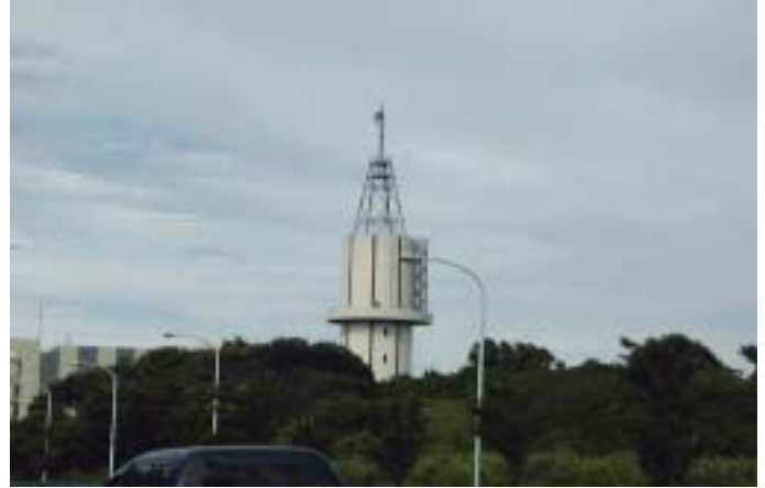
電波塔に類する工作物の親しまれやすい形態の工夫に加え、敷地及び周辺の緑を残し、高さによる突出感を極力抑制している。(多摩市)
