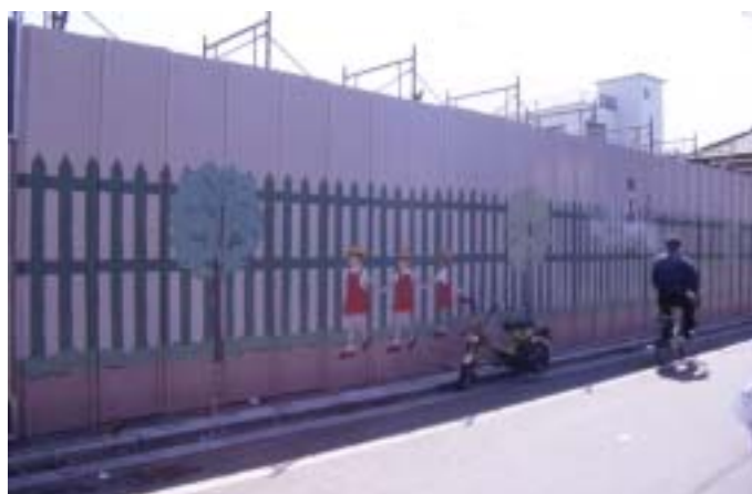
工事用仮囲いにペイントを施し、圧迫感、不安感を与えがちな空間に対し、親しみやすさを演出している。(川越市)
