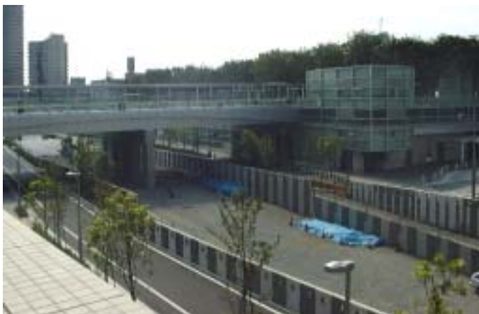
道路と工事区域を仕切る仮囲いは、ストライプ状に設置し、景観面の演出と交通の安全に機能させているほか、のぞき窓もあって工事の様子をうかがうこともできる。(さいたま市)
