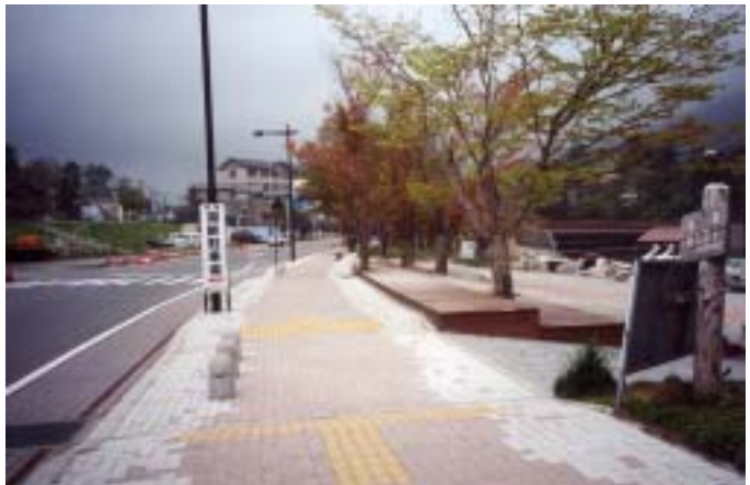
湖畔に面したボードウォークの整備にあたっては、既存樹を残している。(日光市)
