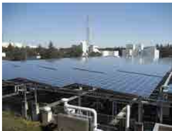
県央浄化センター
