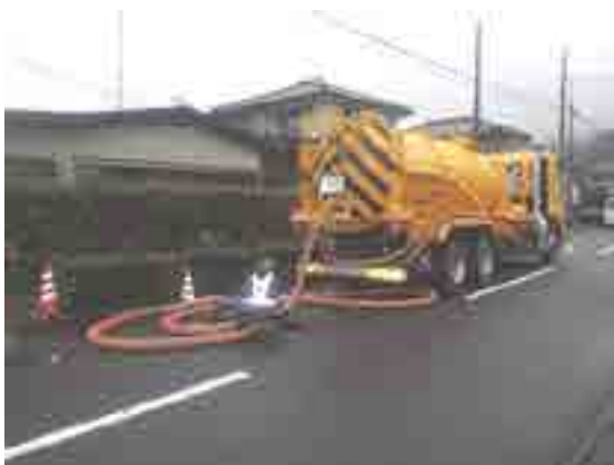
吸引車の使用による溢水防止のための水替え作業
