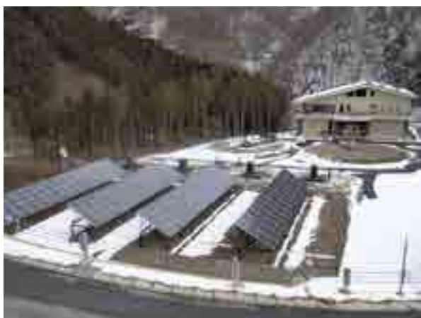
日光市湯西川水処理センター
